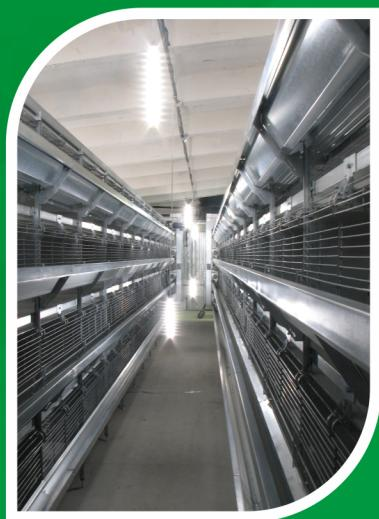
Светодиодное освещение птицефабрики представляет собой компактные лампы, предназначенные для установки на системе подвеса в проходах между клеточными батареями птичника при клеточном содержании.
