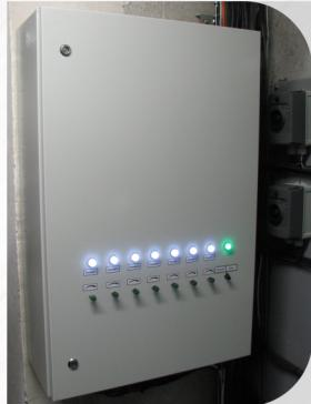
Система проста в обслуживании, конструкция светильника не имеет сложной электроники внутри, поэтому начинка светильника не имеет "слабых мест", управляющие органы светильника находятся в общем шкафу системы питания, поэтому сам светодиодный светильник гарантировано отработает весь заявленный срок службы.
